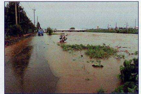
H6出水状況
